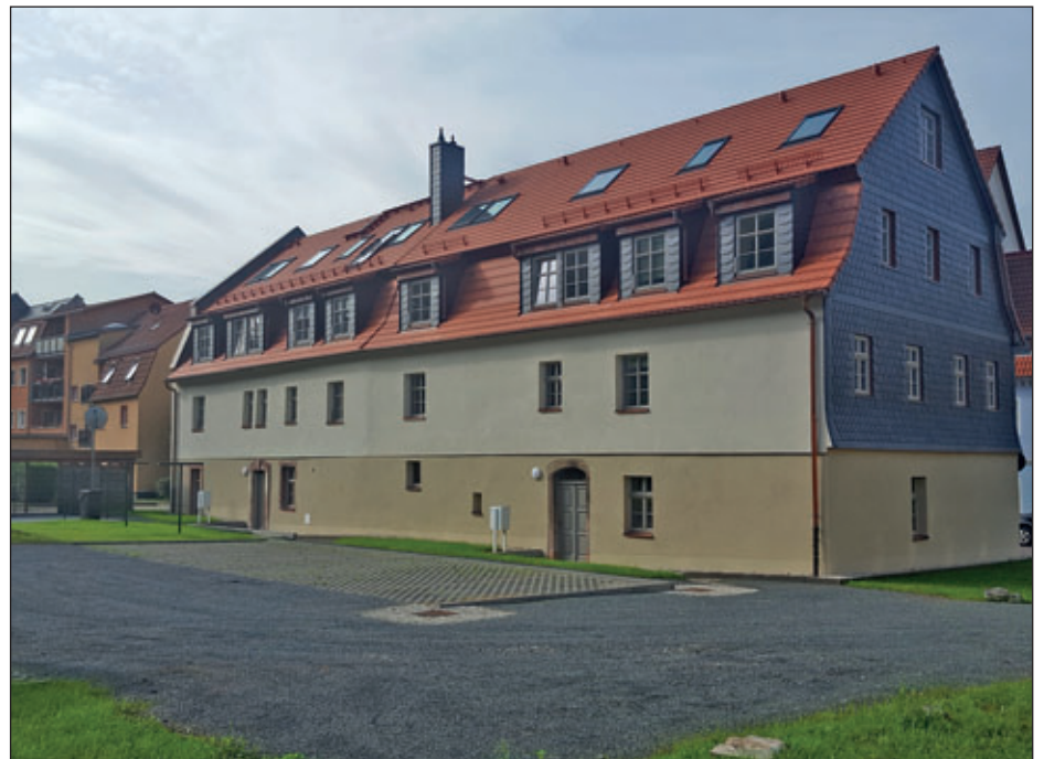
Abschluss der Bauarbeiten auf der Brauhoftstraße 6-8
