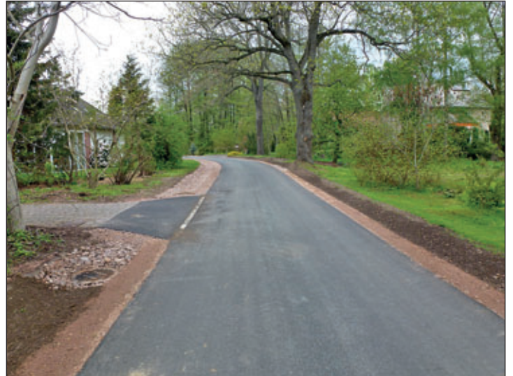
Die Hochwasserschadensbeseitigungsmaßnahme in Berthelsdorf
