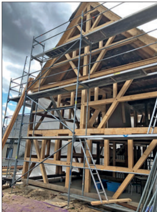
Fachwerkhaus "An den Stufen"
