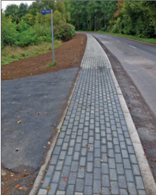
Beendigung der Bauarbeiten Gehweg Cunnersdorf
