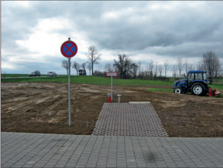
Fertigstellung Zisterne Falkenau
