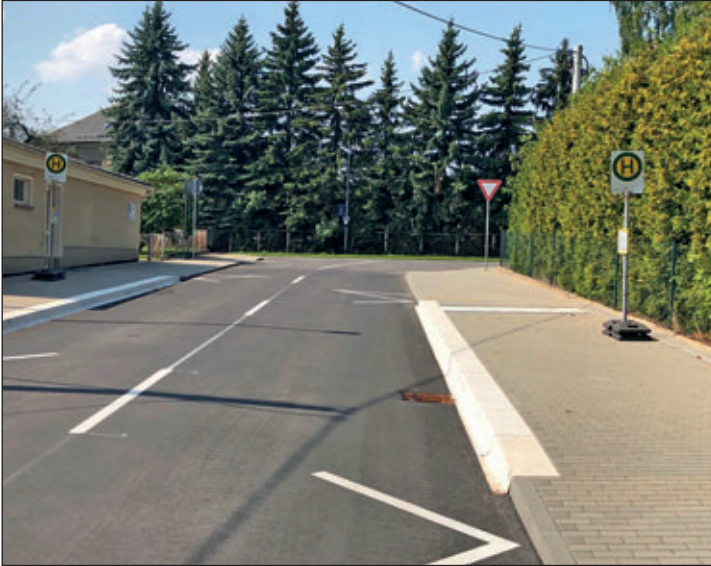
Bitumeneinbau und Errichtung einer neuen Haltestelle auf der Georgenstraße
