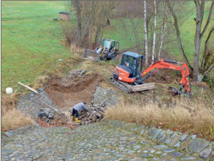
Hochwasserschadensbeseitigung am Saugartenbach im OT Siegfried
