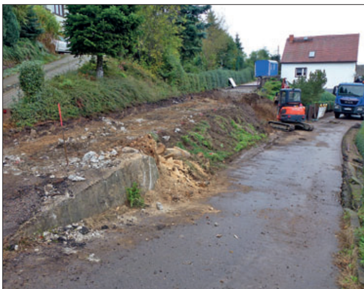
Baumaßnahme Stützmauer Schlegel bald beendet
