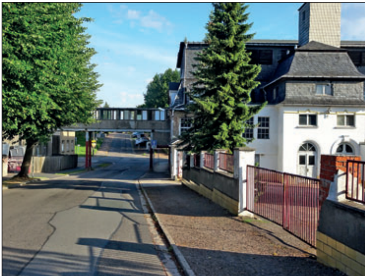
Erwerb durch die Stadt mit dem Ziel des Abrisses der Industriebrache
