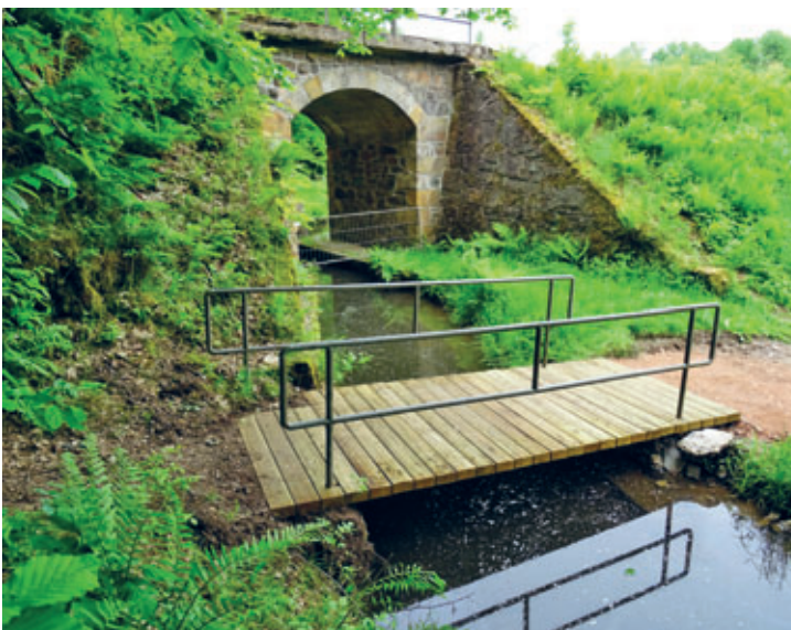
Fußgängerbrücke über den Mühlgraben in Schlegel wieder begehbar
