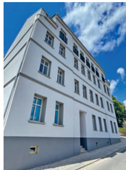
Gebäude an der Mühlstraße 2 ansprechend saniert
