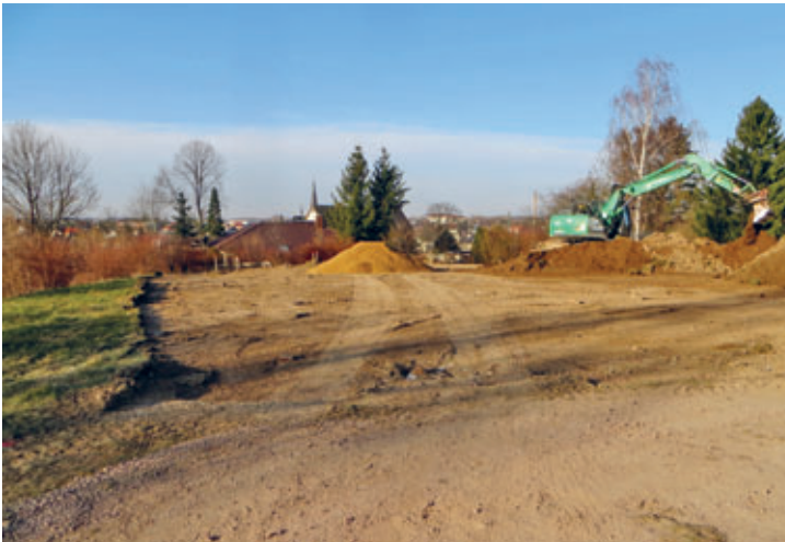
Bau eines neuen Parkplatzes am Sportforum
