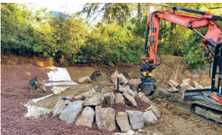
Bauarbeiten am Goldfischteich und an der Blumenuhr im Stadtpark begonnen
