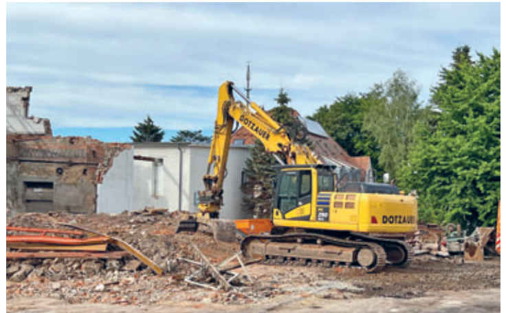
ehemalige Hainichener Lederfabrik wurde abgerissen
