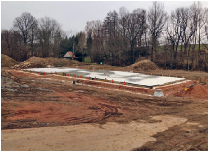
Feuerwegerätehaus in Cunnnersdorf erhielt Bodenplatte im März
