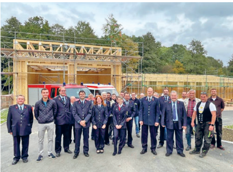
Cunnnersdorfer Wehr feierte am 13.10.2022 Richtfest für das neue Gerätehaus
