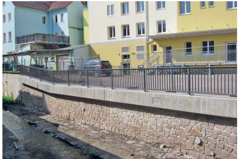
Ersatzneubau der Ufermauer hinter dem Goldenen Löwe fertiggestellt
